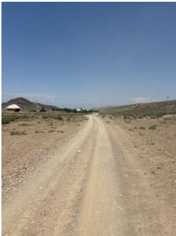
Строительная площадка водохранилища
