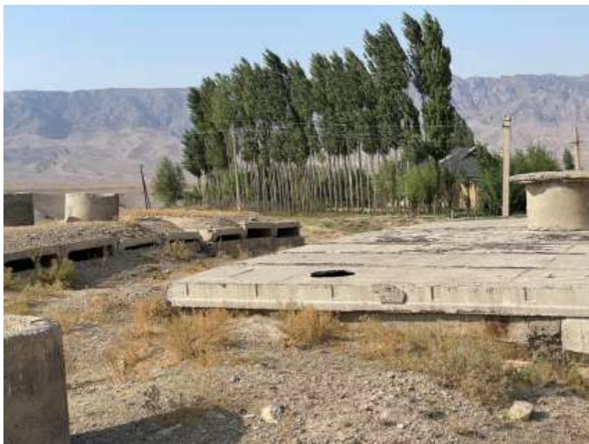
Существующий резервуар, село Сабыров (Фото, сделанное ОРП)
