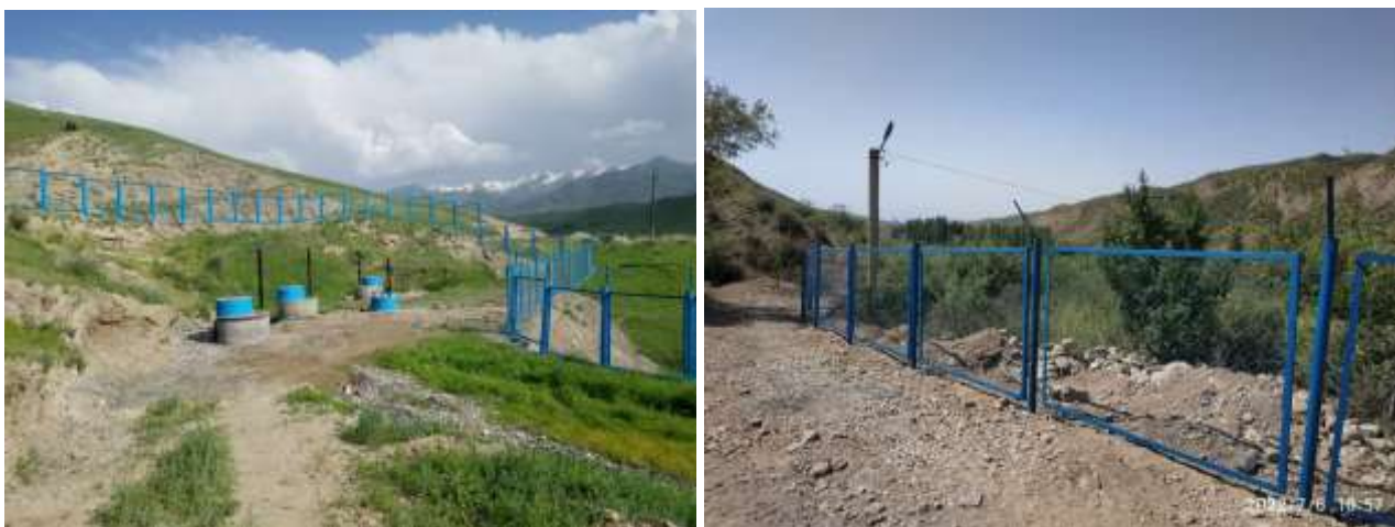
Рисунок 16. Примеры работ на участках подпроекта - Ограждения
