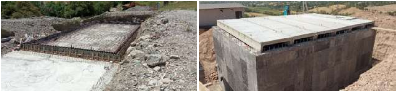
Рисунок 13. Примеры работ на участках подпроекта - бетонные работы - резервуары для воды
