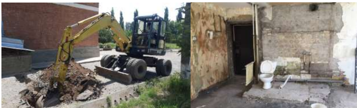
Рисунок 17. Примеры работ на участках подпроекта - Демонтажные работы
