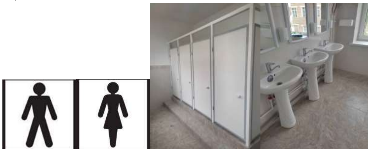
Рисунок 19. Примеры работ на участках подпроекта - Внутренние работы
