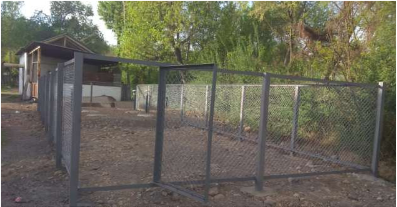
Рисунок 20. Примеры работ на участках подпроекта - Ограждение построенного септика
