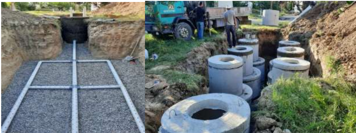
Рисунок 18. Примеры работ на участках подпроекта - Строительство септика
