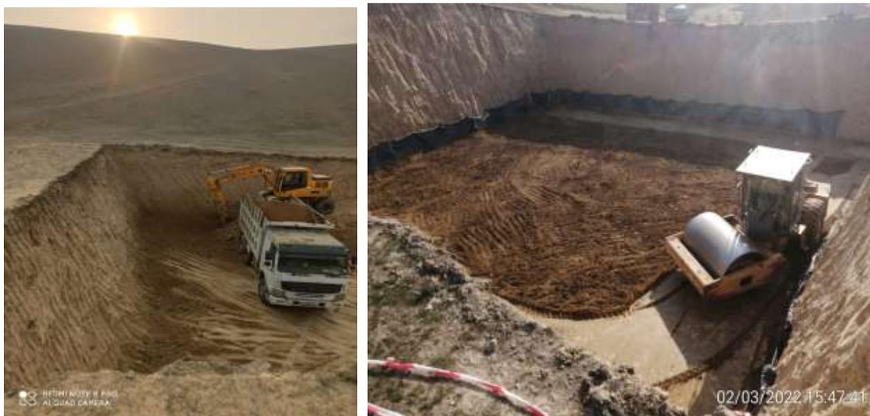
Рисунок 10: Примеры работ на участках подпроекта - поперечное сечение траншеи, глубина котлованов, регламентируется проектом
