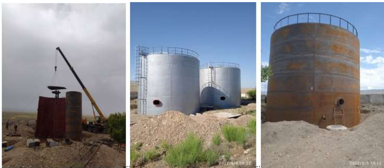
Рисунок 4. Примеры работ на участках подпроекта - Резервуары для воды
