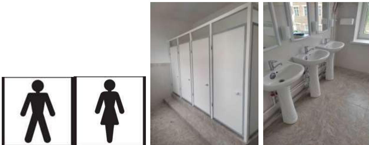
Рисунок 11. Примеры работ на участках подпроекта - Внутренние работы
