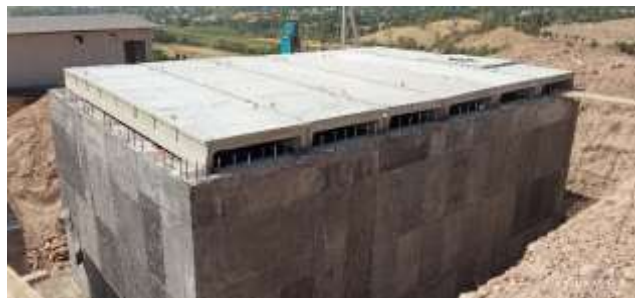
Рисунок 5. Примеры работ на участках подпроекта - бетонные работы - резервуары для воды
