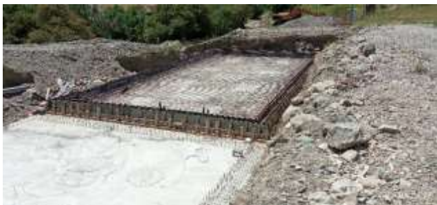
Рисунок 5. Примеры работ на участках подпроекта - бетонные работы - резервуары для воды
