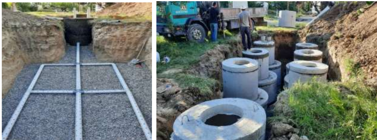
Рисунок 10. Примеры работ на участках подпроекта - Строительство септика
